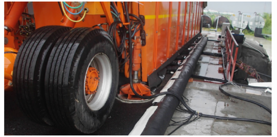
图 13 桥面铺装加速加载试验
