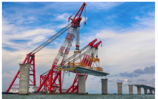
图8 跨越油气管线双浮吊抬吊
