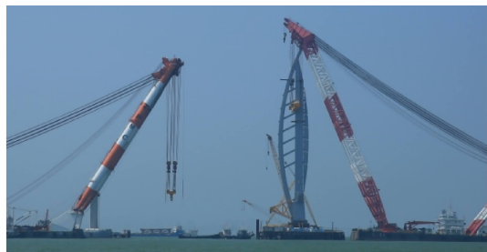
图 10 成功抬吊竖转安装的首个江海桥钢塔
