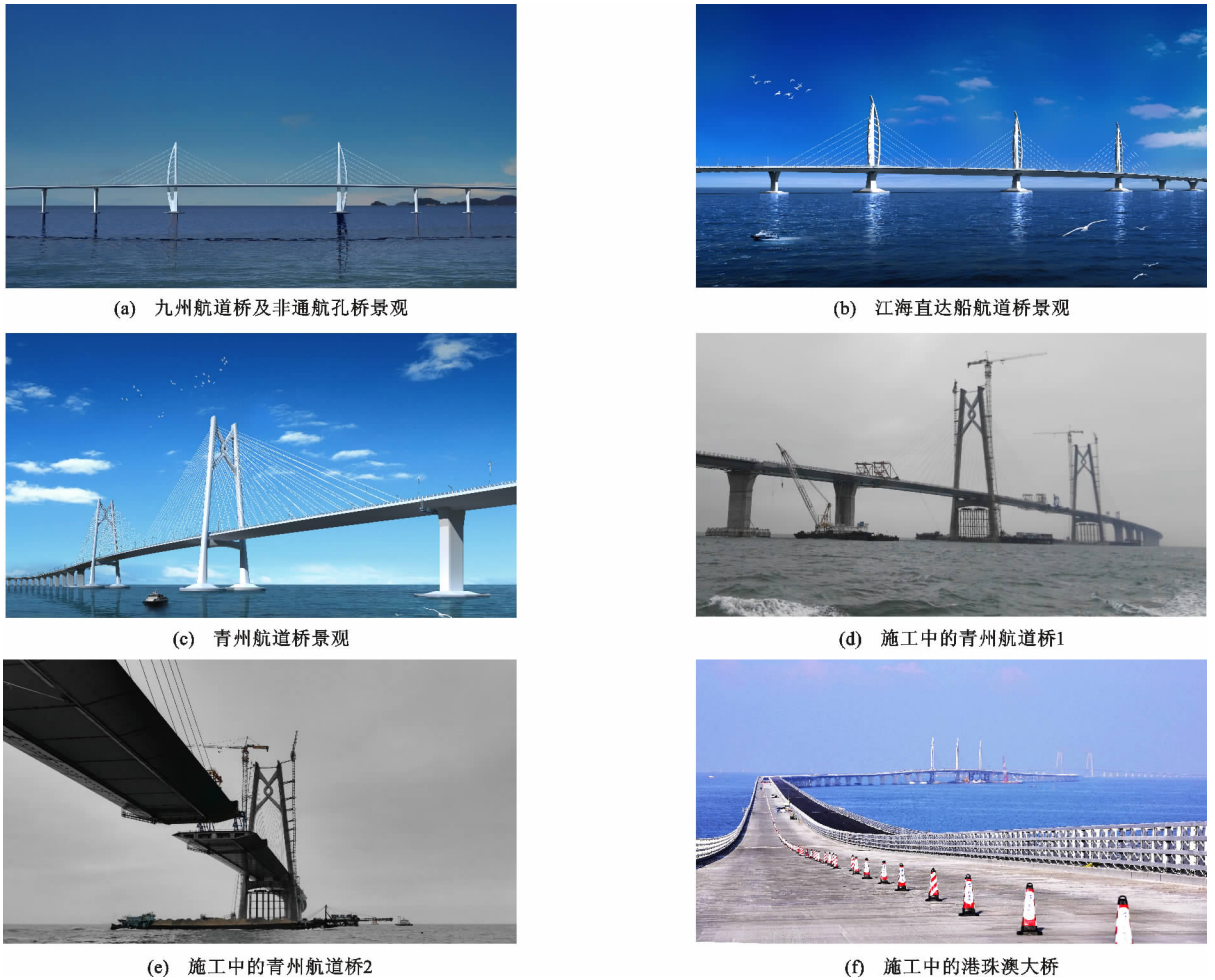
图 2 3 座斜拉桥景观与施工场景
