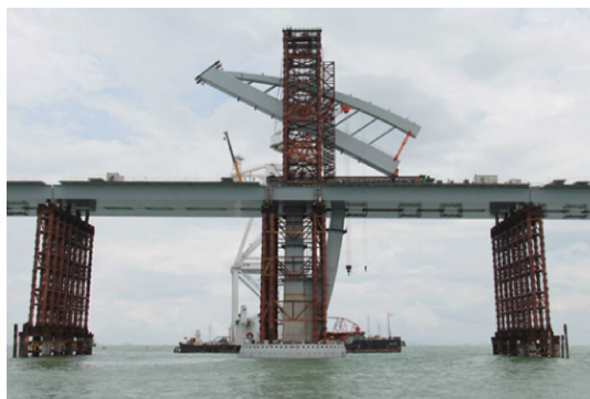
图 9 九州航道桥钢塔竖转
