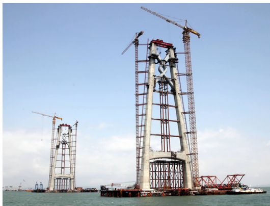
图 11 塔顶吊机吊装结形撑
